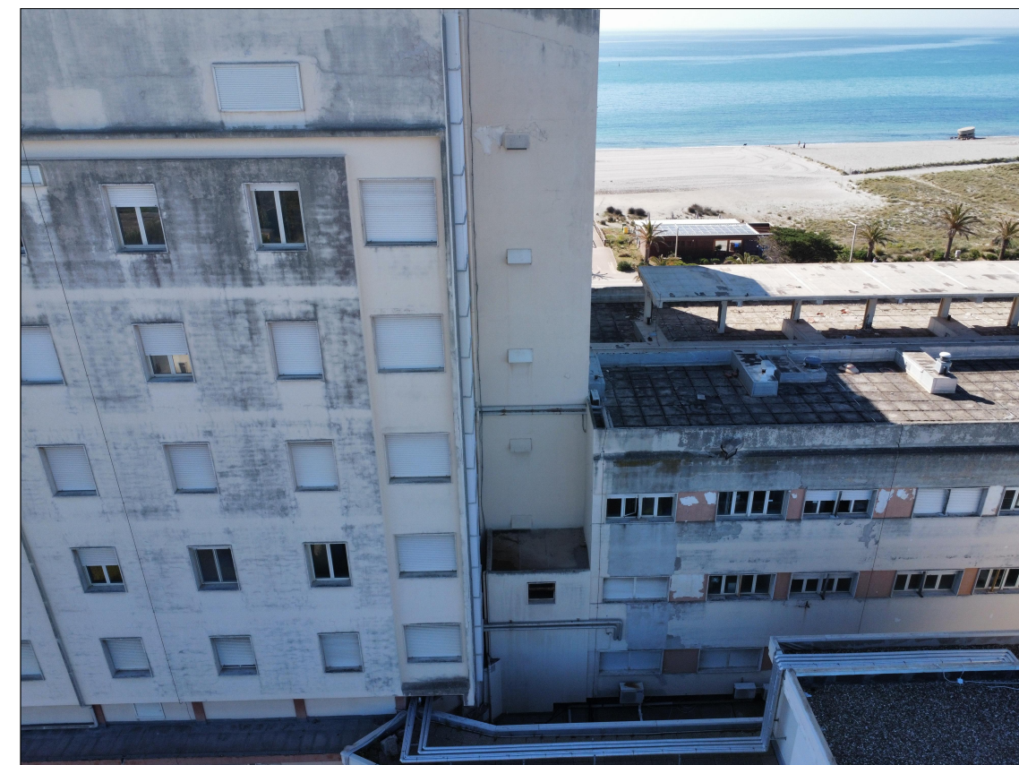
FOTO 3 - Vista aerea dell'area di intervento "B" - prospetto interno
