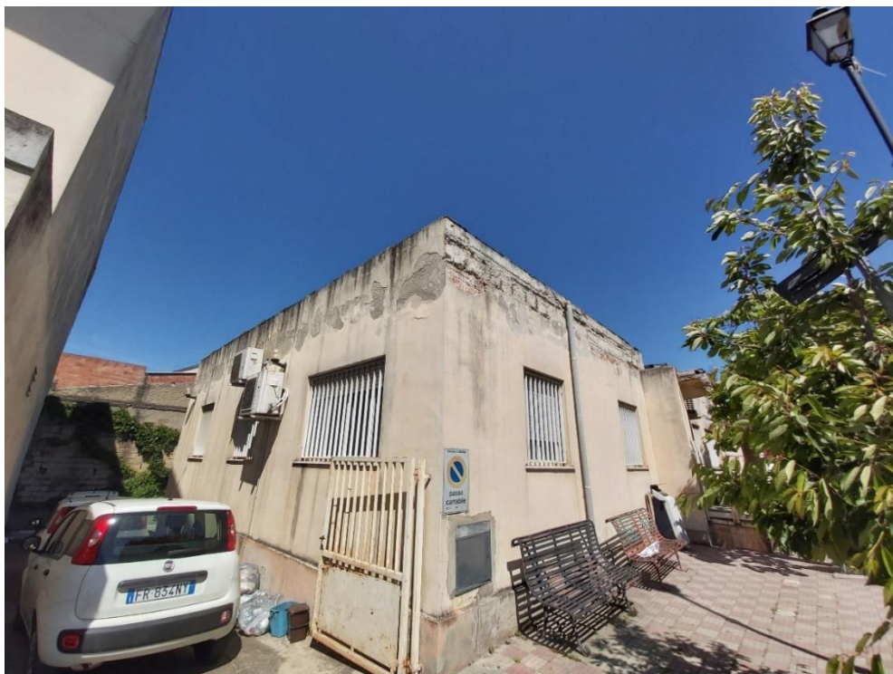
Ingresso cortile CSM Via Carlo Sanna
