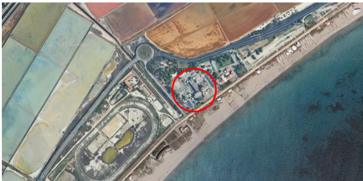
Vista aerea dell'area di intervento e vista dell'immobile
